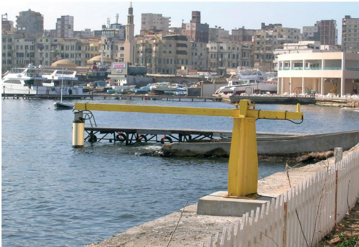
**Figura 4.3** Medidor OTT Kalesto en Alejandría al final de un brazo que se encaja y atornilla en la posición correcta. (Fotografía: T. Aarup, COI).
